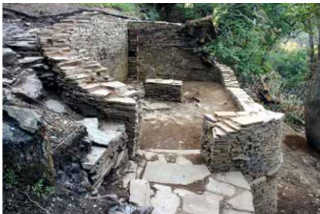
Fig. 12. Vista xeral da vivenda II ao finalizar a intervención, onde se pode ver a disposición da estrutura interior e a cornixa exterior que marca o nivel do chan.
